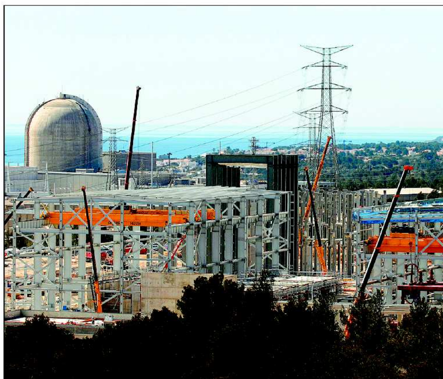
Trabajos de construcción de la central eléctrica de ciclo combinado con la cúpula de la central nuclear Vandellòs 2 (Baix Camp) detrás.
