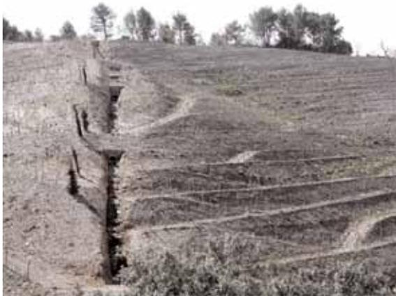
Terrazas con drenaje lateral en zona resistente a la erosión
