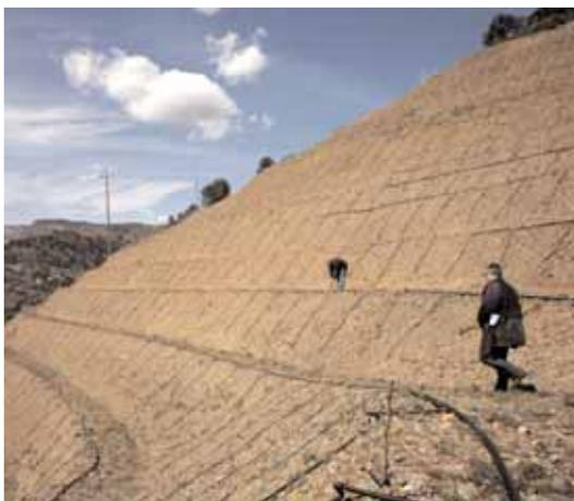
Terreno natural con pendiente superior al 60%. Los taludes no superan los 2 m de altura; plantación en el talud
