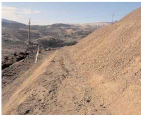
Acabado de taludes de altura constante mediante nivelación con láser
