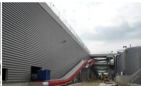
CINTA D'ESTABILITZACIÓ A REFÍ
