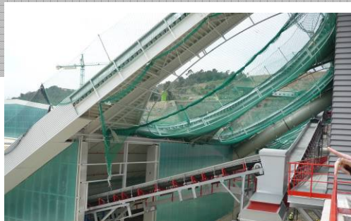
CINTA PRETRACTAMENT A ESTABILITZACIÓ
